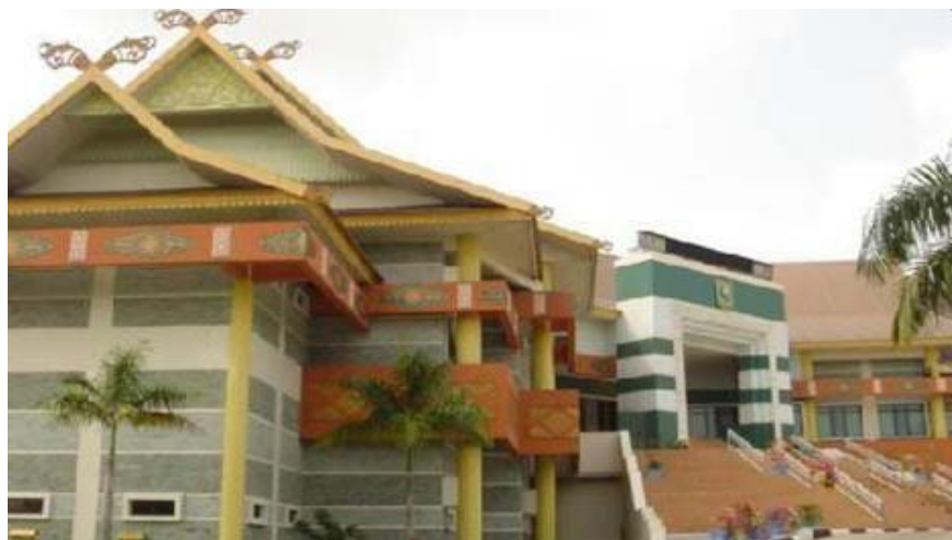
Gambar 13: Gedung DPRD Provinsi Riau yang menerapkan arsitektur langgam tradisional Melayu (Sumber: mediacenter.riau.go.id)
